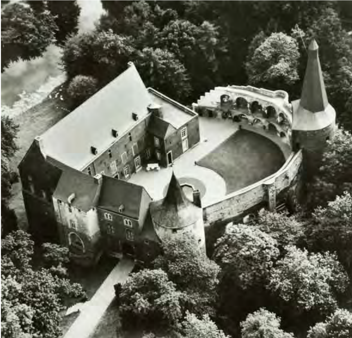
Luchtfoto van het kasteel Horn vanuit het noord-oosten na de restauratie. De oudste delen, uit het tweede kwart van de 13de eeuw, zijn goed herkenbaar daar zij — wellicht nog voor het einde van die eeuw — in mergel werden verhoogd. Links van de 15de eeuwse poort ziet men de poorttoren van de 13de eeuwse burcht. Het hoofdgebouw is in oorsprong 13de eeuws en werd in de 15de eeuw vergroot. (Foto K.L.M.-Aerocarto)
