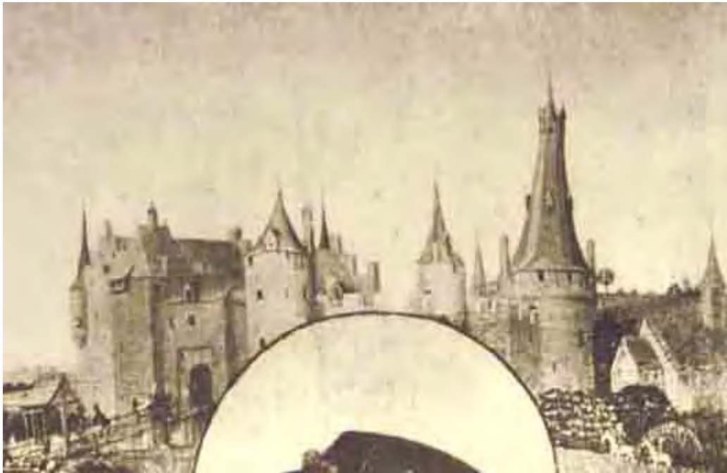
Het kasteel en de kerk van Horn ± 1475, detail van de gedenktafel van Johanna van Meurs. Men ziet de oorspronkelijke poortoren naast de nieuwe poortvleugel
